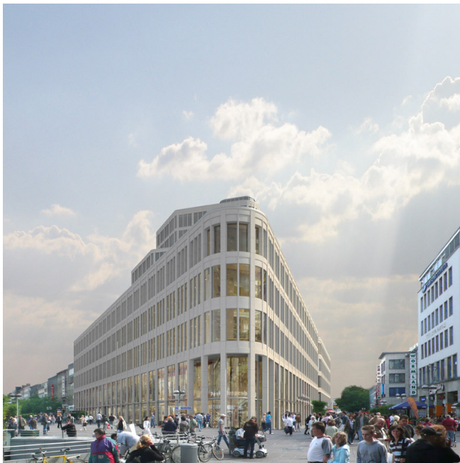
Kröpcke Center – Das alte, in den 70er Jahren errichtete Gebäude weicht zukünftig einem modernen Geschäftshaus.
